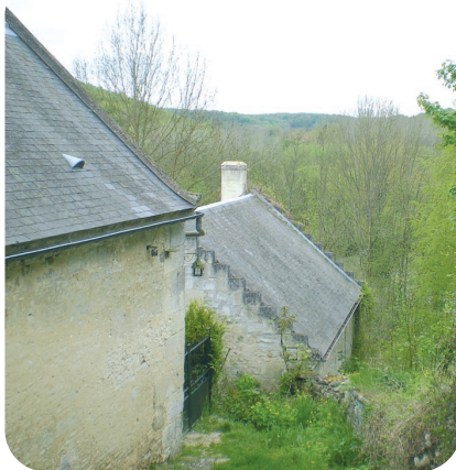
Des maisons aux toits crénelés surplombent une vallée profonde.
